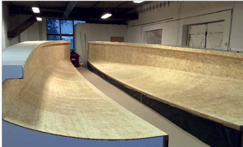
Elkészültek az építősablon famunkái
