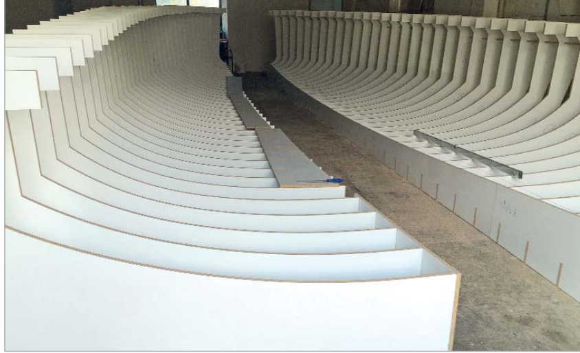
A felállított építőbordák
