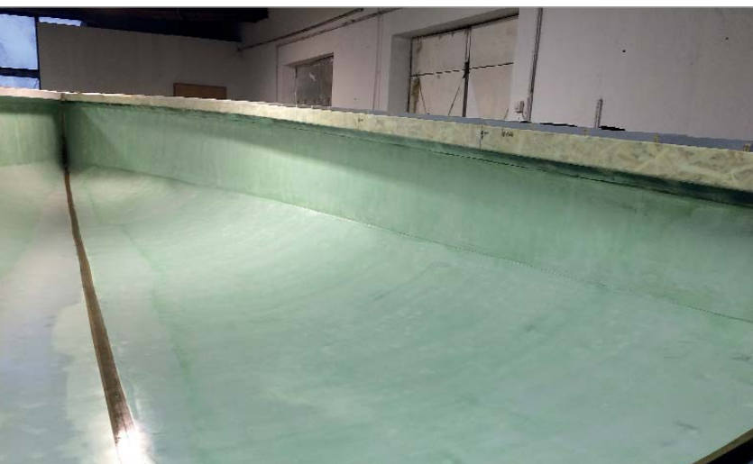
Az építősablon egyben, formaleválasztó felhordása után
