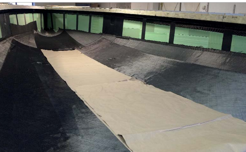
Az utolsó karbonrétegek beterítése
